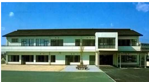
Centro de Bem-Estar Comunitário Oshimizu da Cidade de Toyohashi
